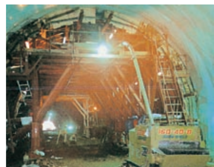
定置式コンクリートポンプを架台車に乗せてセトルへ打設する
