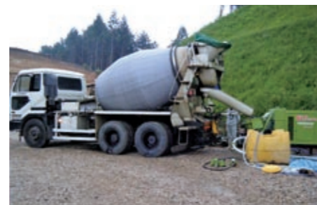
地上に定置式コンクリートポンプを置いて深礎杭の吹付けをする
