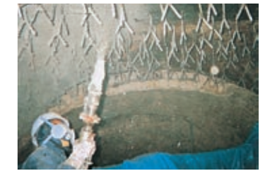
定置式コンクリートポンプを置いて配管し、炉材を吹付け、または打設をする
