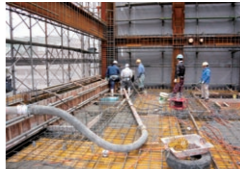
地上の狭い場所に定置式コンクリートポンプを置いて階上の打設をする
