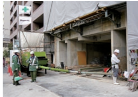
地上の狭い場所に定置式コンクリートポンプを置いて階上の打設をする
