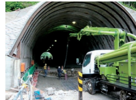
坑口にブーム車を置いて打設する
