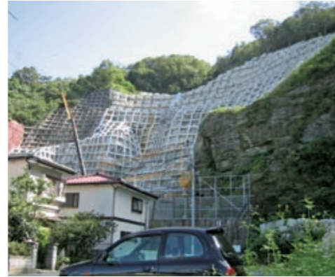
地上に定置式コンクリートポンプを置いてSLPショット工法(特許)により吹付けをする
