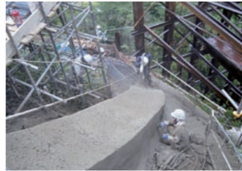
地上に定置式コンクリートポンプを置いて深礎杭の吹付けをする
