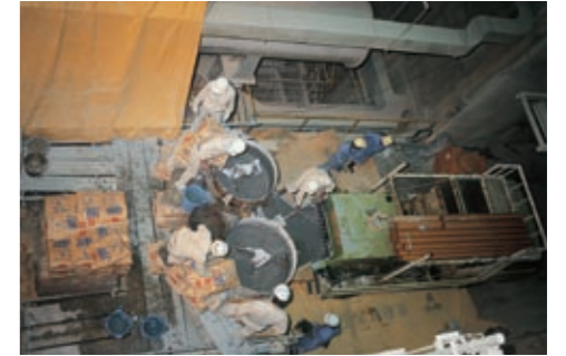
定置式コンクリートポンプを置いて配管し、炉材を吹付け、または打設をする
