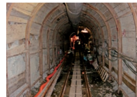
レール工法による打設
