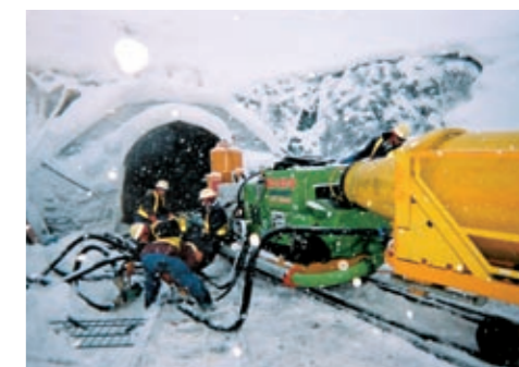
レール工法による吹付け
