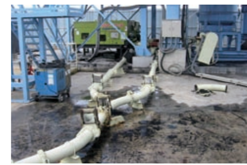
火力発電所の石炭灰を圧送
