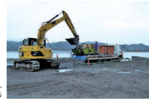
泥土を配管により、所定の場所まで圧送する
