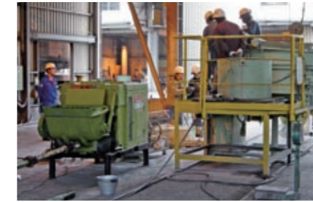
定置式コンクリートポンプを置いて配管し、炉材を吹付け、または打設をする
